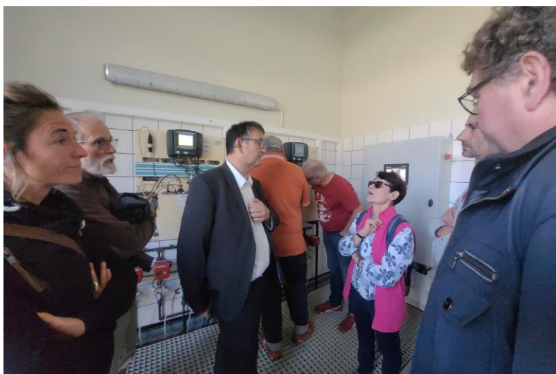
La visite du captage et des installations de traitement de l'eau brute
