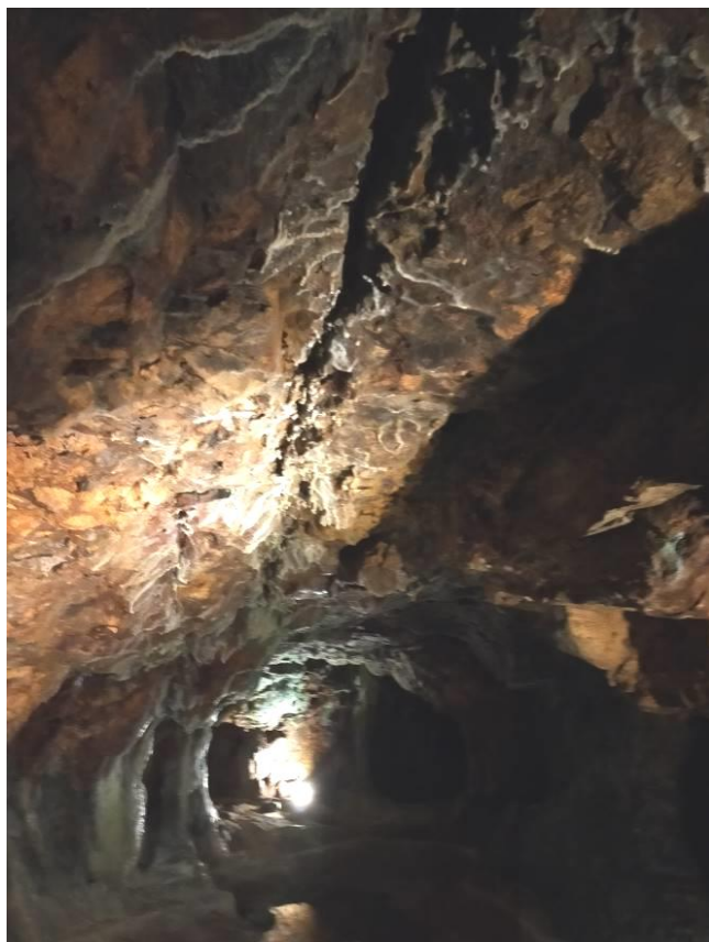
Vue des galeries de mines (forme arrondie liée à la méthode d'extraction par le feu)
