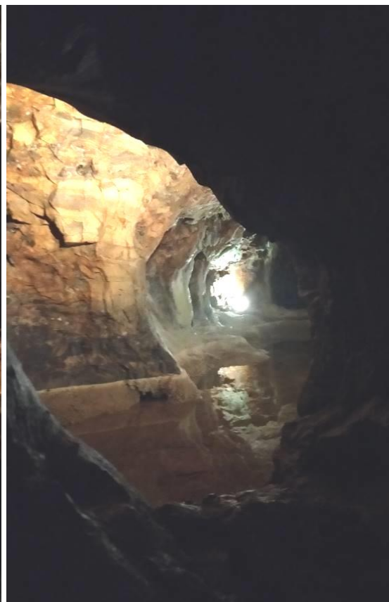
Vue des galeries de mines (forme arrondie liée à la méthode d'extraction par le feu)
