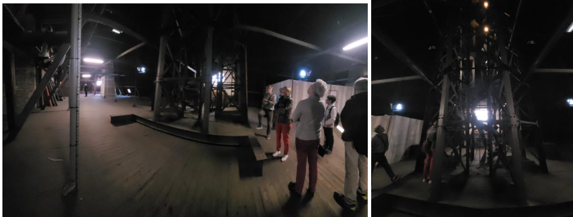
Les combles et l'accès à la vigie (Mairie de NIORT).
