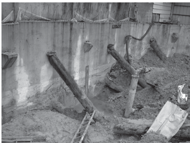
▲ Photo 9. Pompage du fond de fouille par champ captant (source : GTS).
