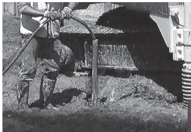
▲ Photo 10. Mise en œuvre d'une jupe injectée (source : GTS).
