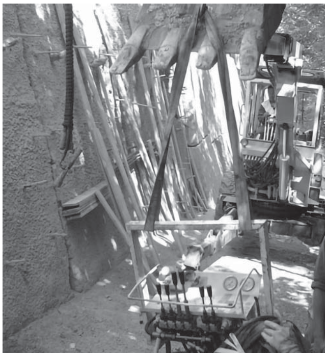
▲ Photo 1. Réalisation d'une paroi clouée (source : GTS).
