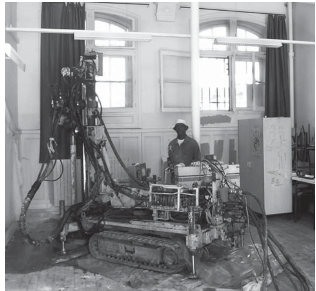
▲ Photo 17. Flexibilité de la solution par micropieux (source : GTS).
