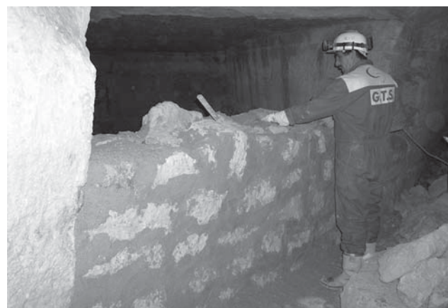
▲ Photo 6. Muret périmétrique (source : GTS).
